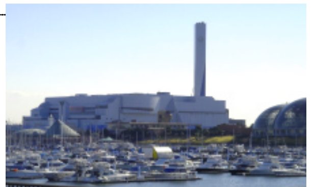
夢の島ヨットハーバーの向こうにそびえる巨大な新江東清掃工場(600ト×3炉)。10年3月、工場を中心に周辺の松葉を採取しダイオキシン・重金属調査を行う。市民による環境監視活動を地道に継続していく。
